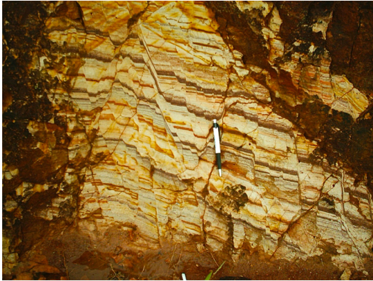
FIGURA 4 – Falhas normais e inversas em arenitos da Formação Pirambóia, em contato com intrusão de diabásio alterado. Localização: UTM 211.753E; 7.478.464N (Serra da Floresta).
