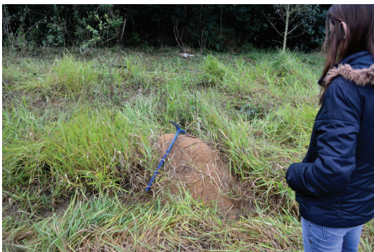
FIGURA 10 – Cupinzeiro na borda do tecnobioma de talude de corte.
