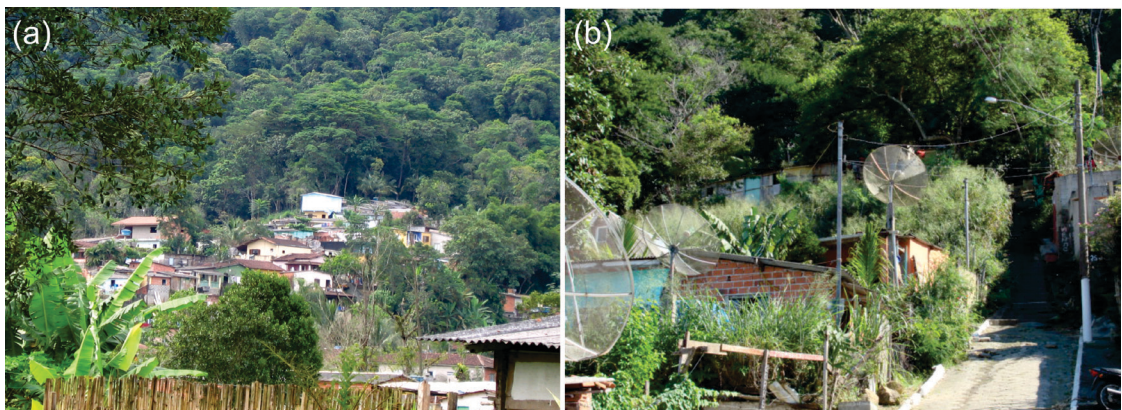
FIGURA 4 – (a) Vista geral da ocupação na Área 3 (Vila Baiana); (b) detalhe de moradias construídas em encosta com declividade acentuada (Fonte: Acervo IG-SMA, 2005).
