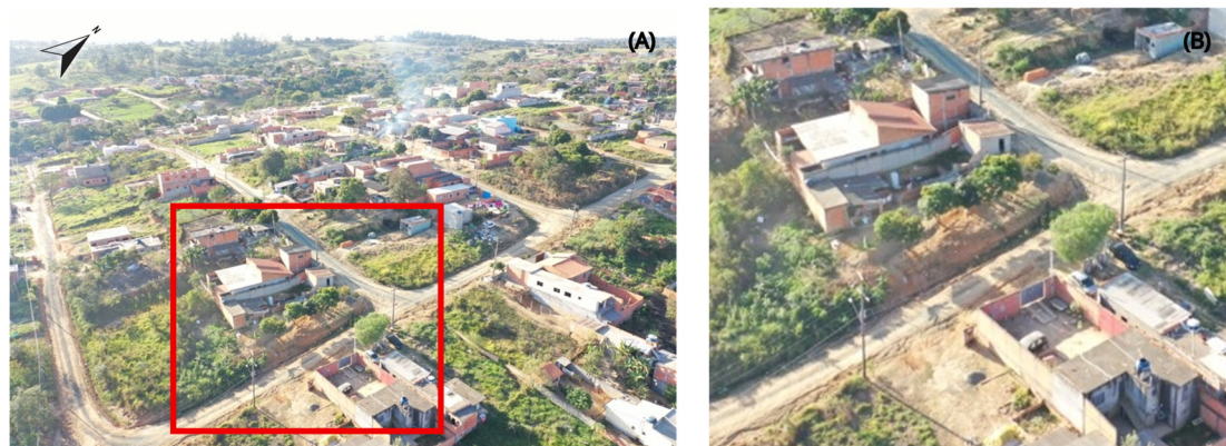
FIGURA 9 – (A) Vista aérea de loteamento em área periurbana no Trecho Córrego Água Comprida; (B) Detalhe de cortes e taludes expostos em arruamentos não pavimentados. Notar exposição do talude fruto de corte e a suscetibilidade à erosão. Fonte: Prefeitura Municipal de Monte Mor (SP), abril de 2019.
