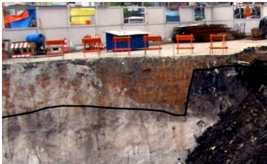
FIGURA 14 – Diferentes profundidades de impacto nos materiais pré-perturbação evidenciadas pelo contato entre os depósitos tecnogênicos e os sedimentos fluviais. À esquerda, onde era a Av. Faria Lima, a espessura dos depósitos tecnogênicos é maior, ao contrário da direita, onde se localizava o calçamento e as edificações do bairro. Fonte: LUZ (2010).
