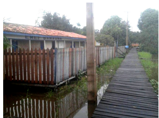
FIGURA 21 – Marcas de inundações em poste. Fonte: ALVES (2017).
