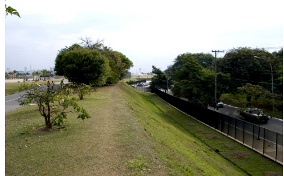
FIGURA 5 – Aterro do Parque Villa-Lobos. Obs.: A rua representa a altura da antiga planície de inundação. Fonte: RODRIGUES (2006). Foto: Eduardo Justiniano.
